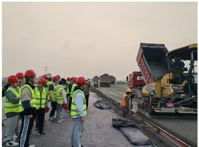
图4 观摩襄阳路桥襄南高速公路水稳基层摊铺现场
